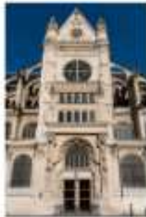
La façade de l'église Saint-Eustache [2]
