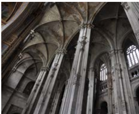
Détail d'architecture : ornementation Corinthienne
